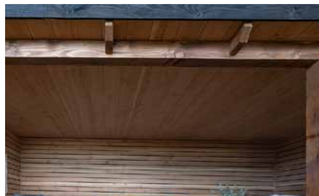
LUXE PLAFOND AFWERKING Elektra t.b.v. verlichting is eenvoudig te verwerken in de dakpanelen
